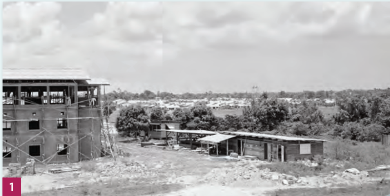
Een school in aanbouw
