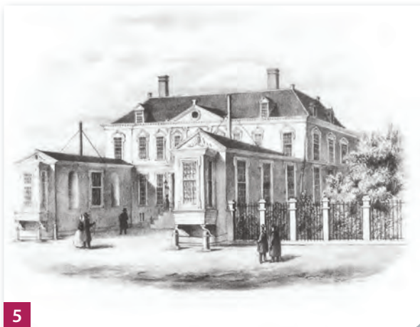
Gebouw van het Ministerie van Koloniën
