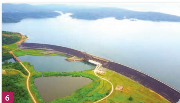
Een luchtfoto van de stuwdam
