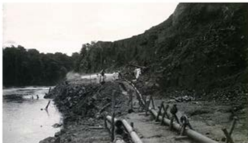
Met een zeer sterke waterstraal werd de Maabo-heuvel afgespoten (1907)
