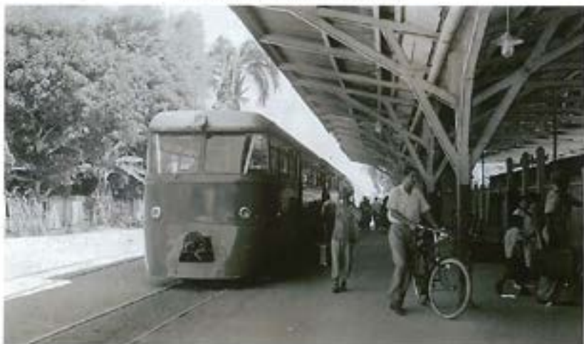
Gloednieuwe dieseltrein in december 1954 op het station bij het Vaillantsplein. Het treinstel heeft nog geen nummer
