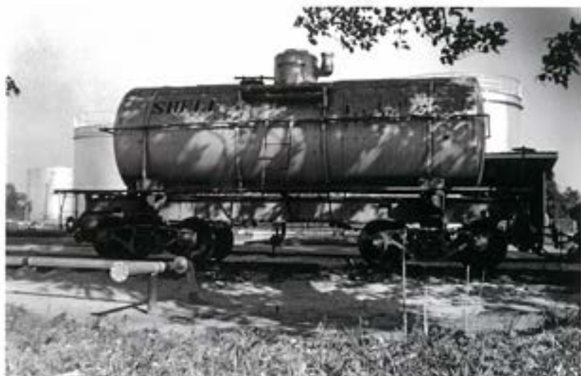
Tankwagen voor het vervoer van vliegtuigbenzine van de aanlegsteiger in Beekhuizen naar Zanderij (1959)
