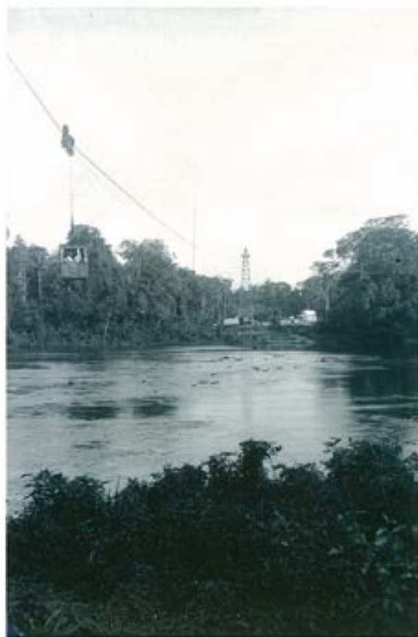
Kabelinstallatie met passagierscabine over de Surinamerivier bij Kabel Station, omstreeks 1915. In de cabine was plaats voor twaalf personen
